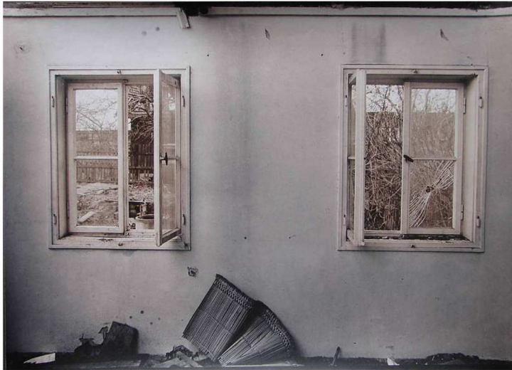
Hrázděné stěny byly vybaveny relativně malými kastlovými okny, dodávajícími domkům venkovský charakter. Foto: Ivo Filip .
