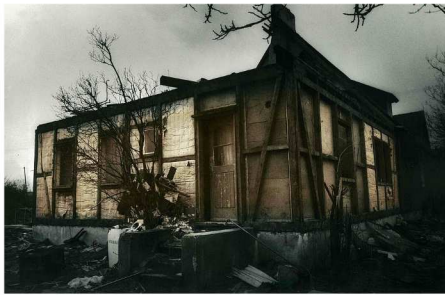
Na částečně rozebraném domku v kolonii Hamburk je dobře patrná hrázděná konstrukce stěn s tepelnou izolací. Foto: Ivo Filip .
